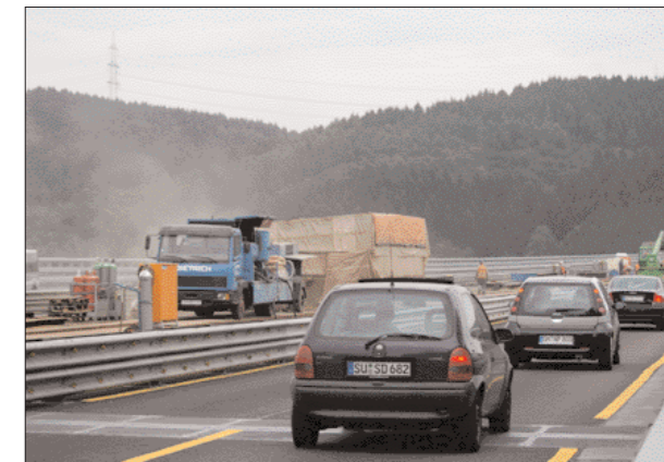
Die A 4 vor Gummersbach bekommt für gut anderthalb Jahre eine Dauerbaustelle.
